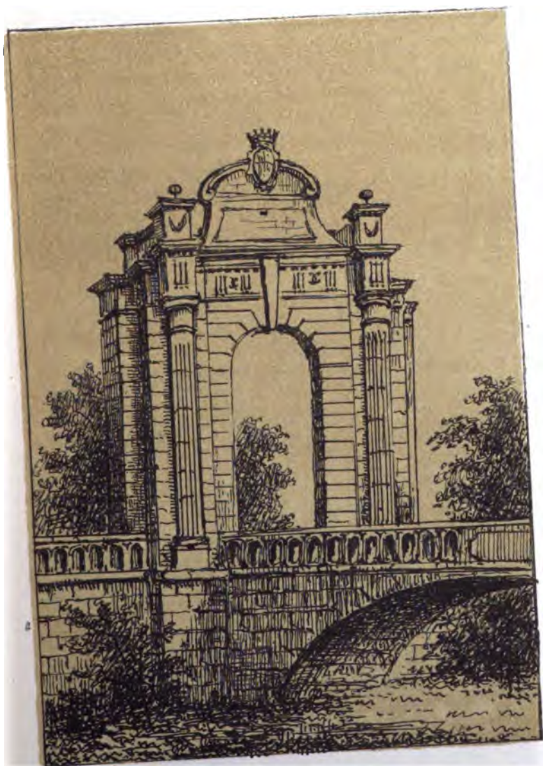
PORTE DU CHÂTEAU DE BÉRRANCOURT.
